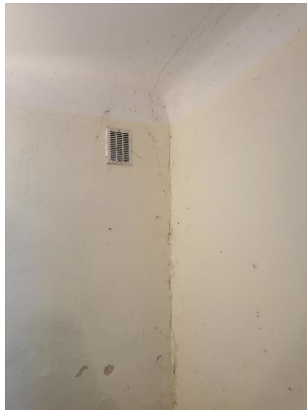
Zarysowania tynku na suficie
