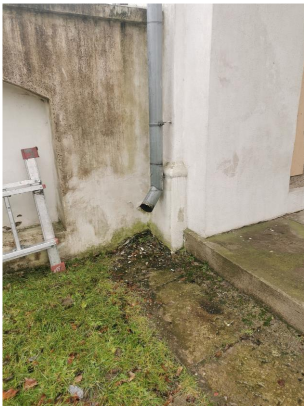
Odprowadzenie wód opadowych - widoczne zawilgocenia ścian w rejonie rur spustowych
