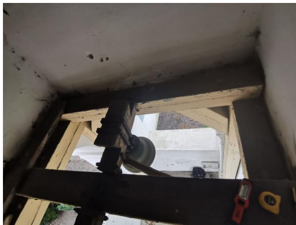
Widok belek wieńczących konstrukcję pod dzwon
