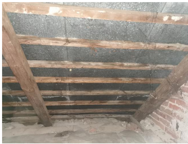
Widok na więźbę dachową - widoczne zawilgocenia łąt
