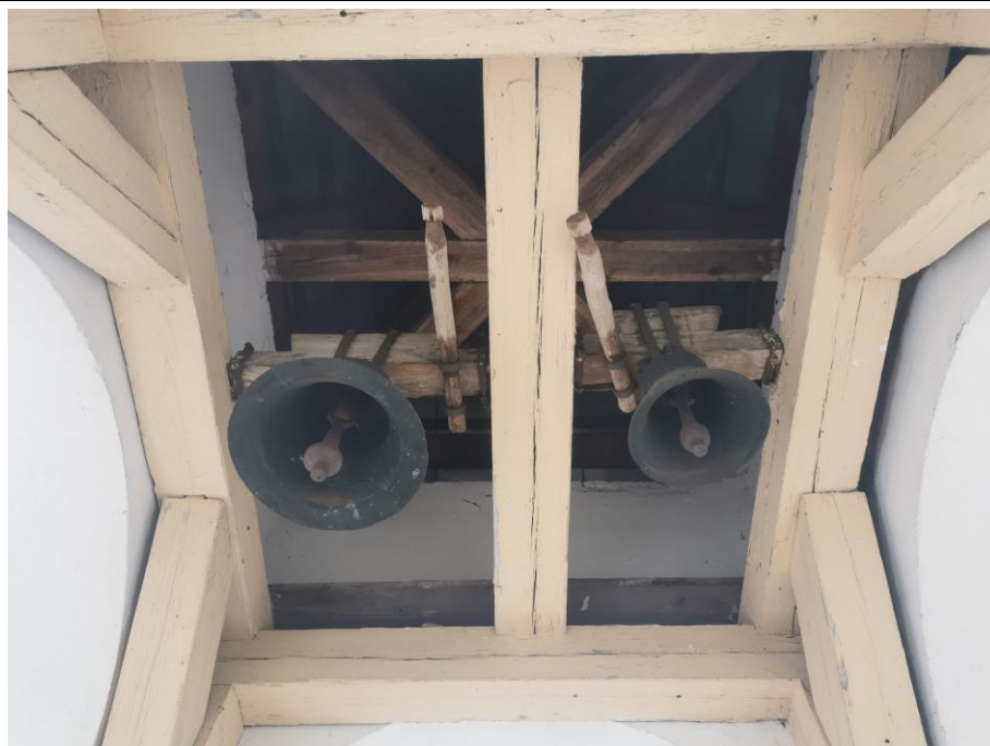
Widok rusztu wieńczącego konstrukcję wsporczą jarzma dzwonów
