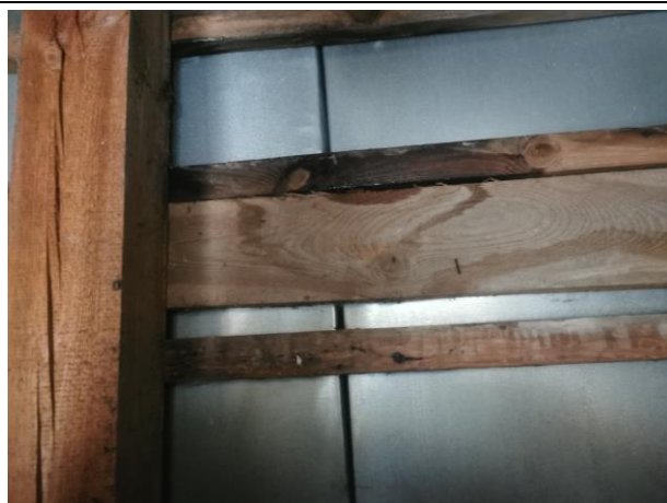
Zawilgocenia łąt spowodowane nieszczelnością pokrycia
