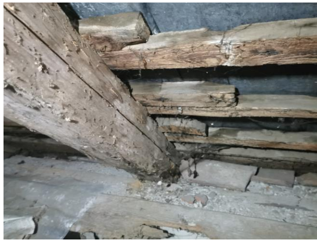
Uszkodzenia krokwi na styku z belką stropową
