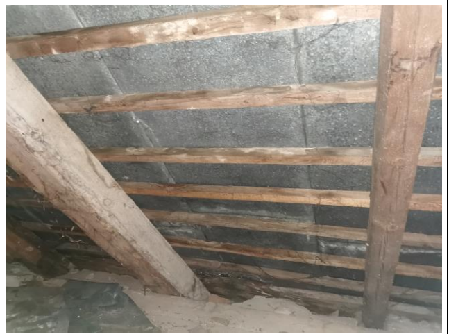
Widok na więźbę dachową - widoczne zawilgocenia łąt
