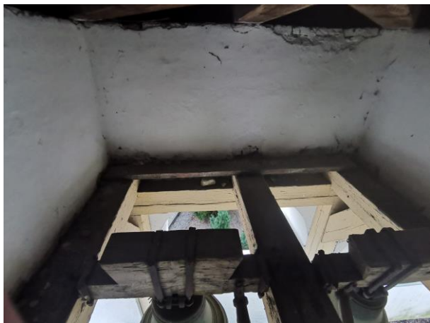
Widok belek wieńczących konstrukcję pod dzwon
