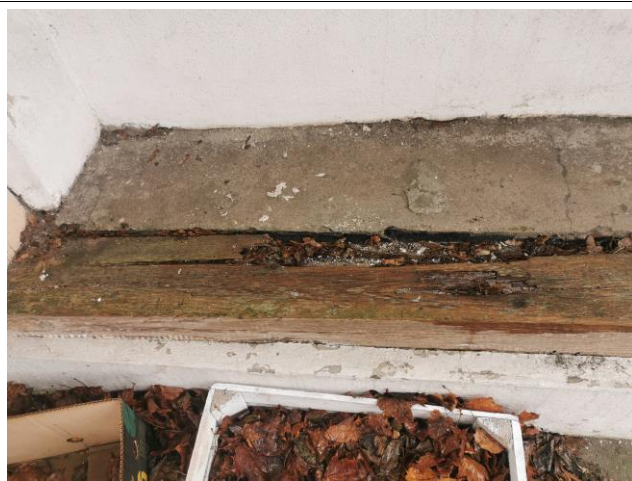
Belka podwalinowa słupów od strony dawnej kostnicy - widoczne uszkodzenia
