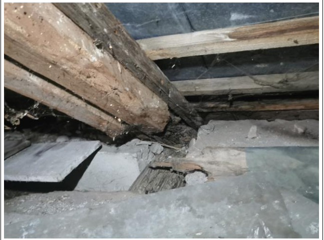
Uszkodzenia krokwi na styku z belką stropową
