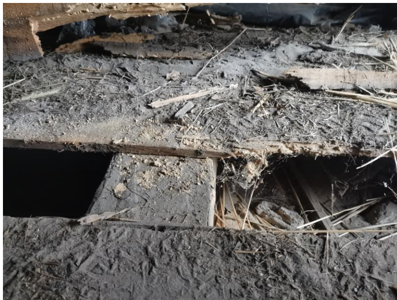
Widok belki stropowej i poszycia z desek
