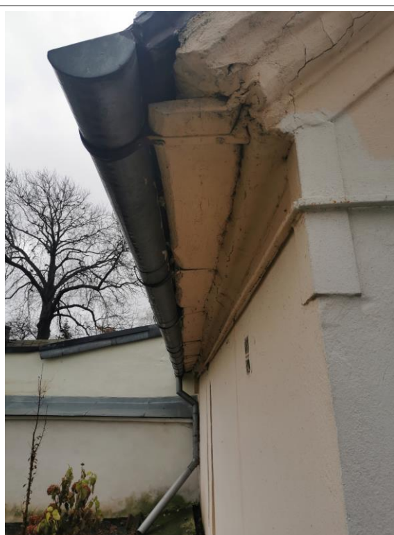
Uszkodzenia profili ciągnionych gzymsu nad ścianą szczytową
