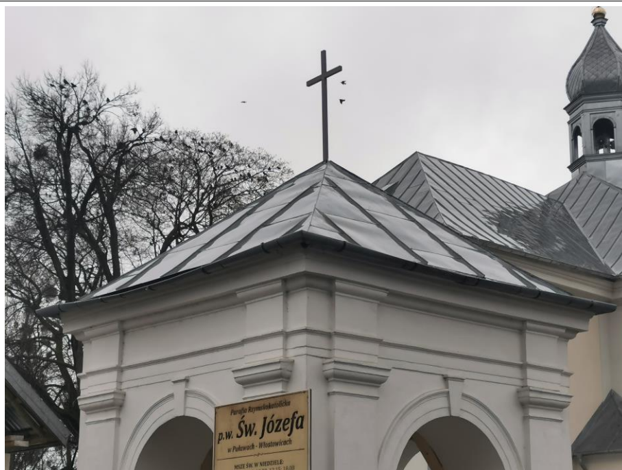
Widok połaci dachu - widoczne deformacje rynien
