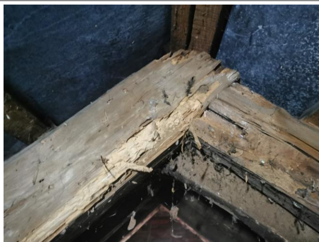
Węzeł kalenicowy - widoczna korozja biologiczna krokwi
