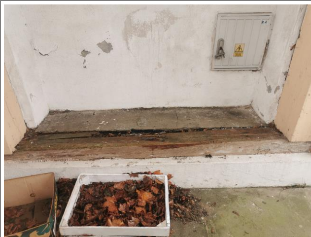
Belka podwalinowa słupów od strony dawnej kostnicy - widoczne uszkodzenia
