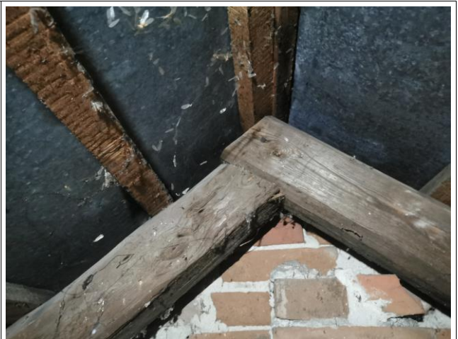
Węzeł kalenicowy - widoczna korozja biologiczna krokwi
